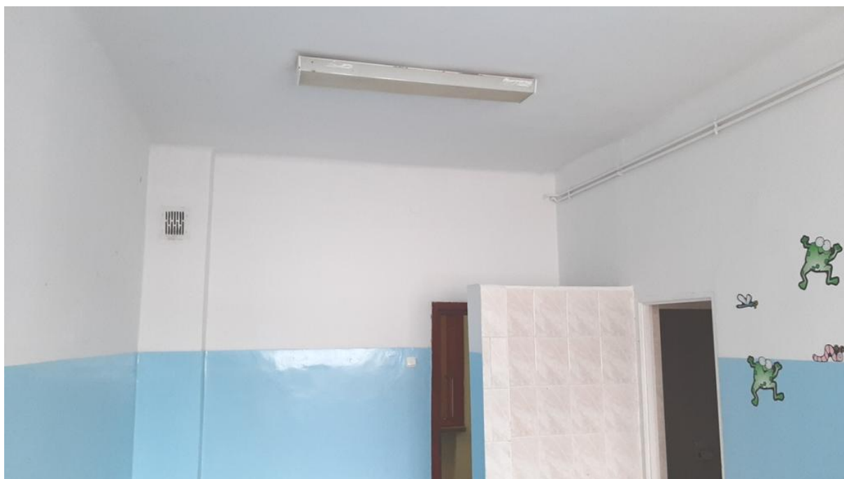
Istniejące pomieszczenie szatni
