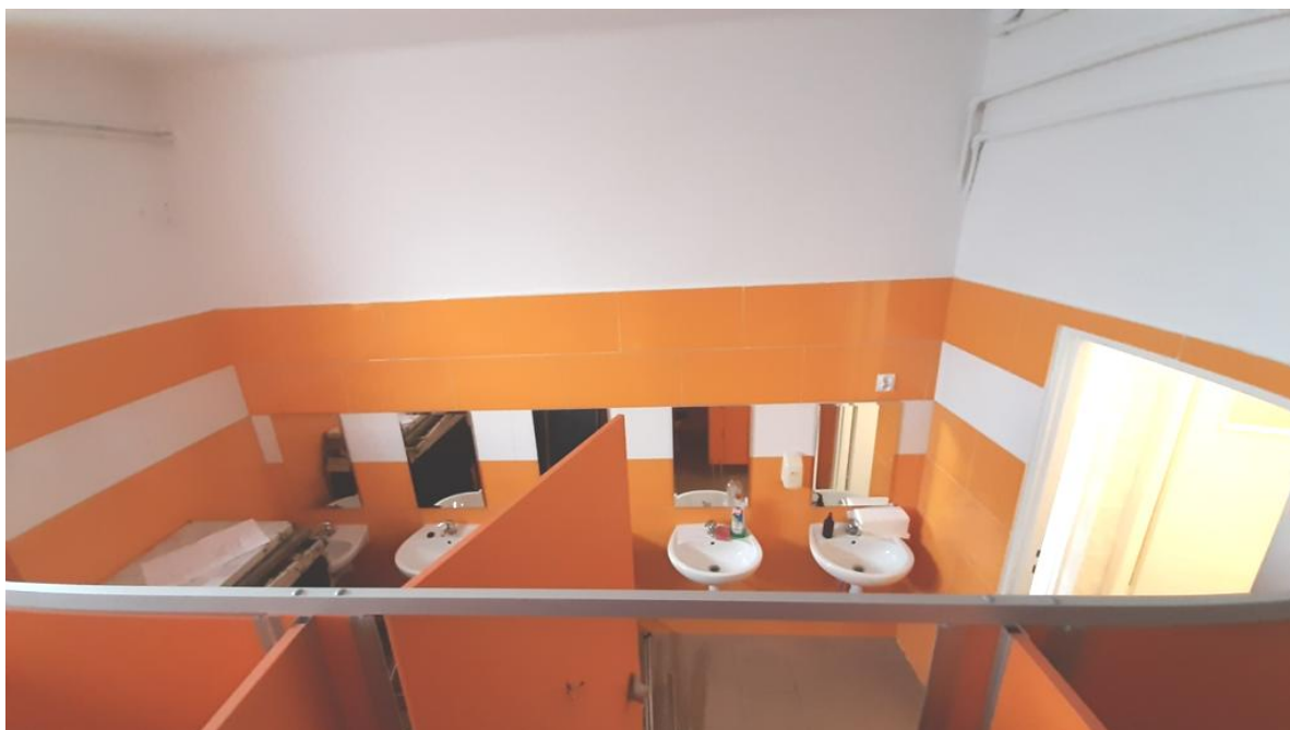
Istniejące pomieszczenie umywalni
